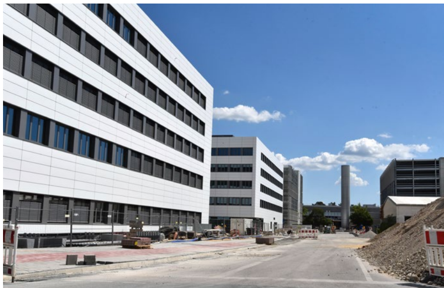
Siemens Campus in Erlangen: Die Bauarbeiten für den zweiten Abschnitt des Großprojekts laufen wie geplant.
