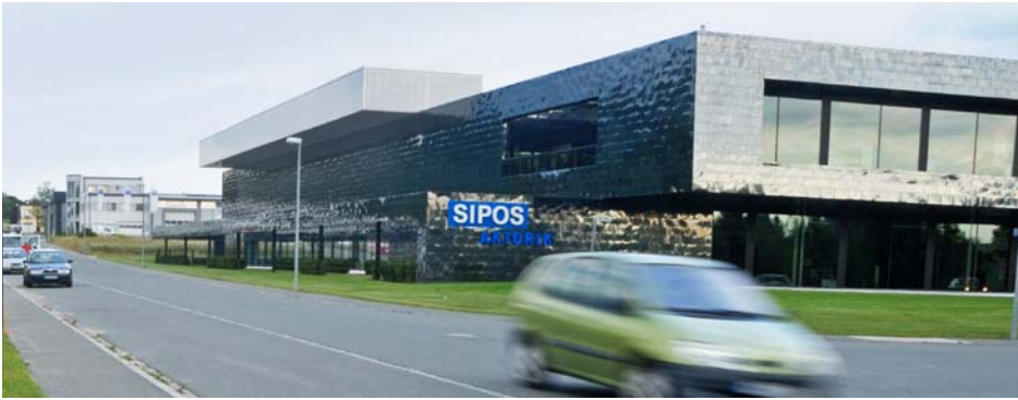
Gewerbepark Altdorf: Der Büro- und Produktionskomplex der Firma Sipos Aktorik beeindruckt mit einer modernen Fassade aus Edelstahlschindeln.
